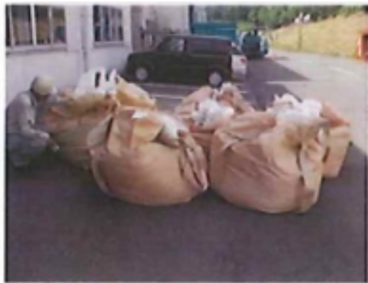
破砕した廃棄物を1m 3 大型土のうに半分(約0.5m 3 )充填
