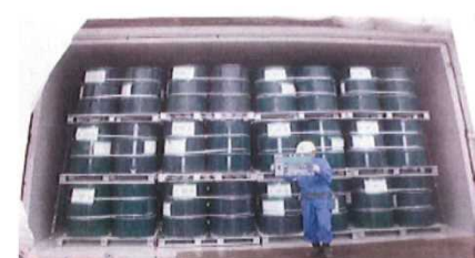
(焼却灰をドラム缶に詰めコンクリートカルバート内で保管)
