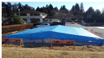
(天日乾燥床をブルーシートで被覆)
