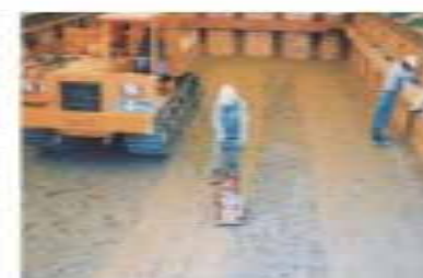
覆土施工状況
