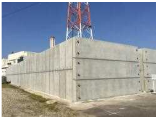
ボックスカルバートの設置
