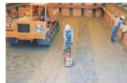
覆土施工状況
