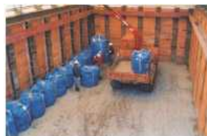
廃棄物定置作業
