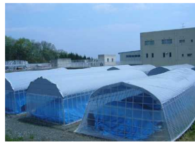
浄水発生土 (浄水施設内など)
