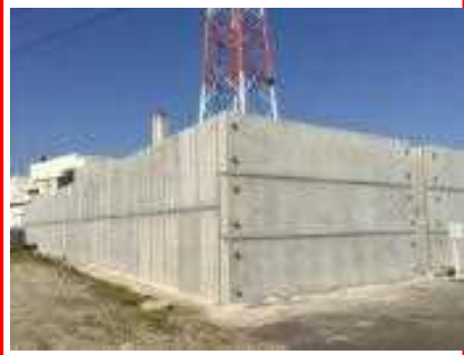
ボックスカルバートの設置
