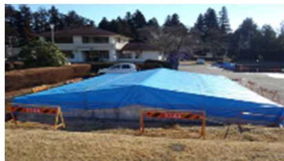
（天日乾燥床をブルーシートで被覆）
