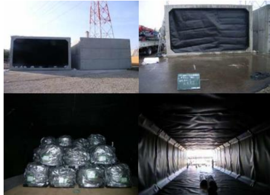
焼却灰をフレキシブルコンテナに詰めボックスカルバート内に保管
