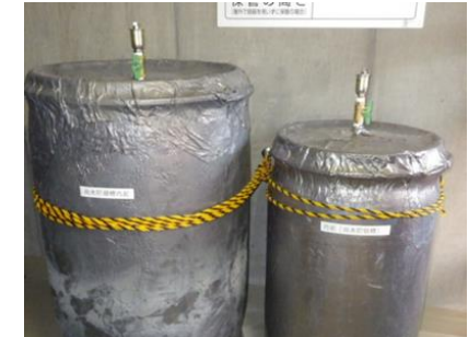
ロープで壁に固定
