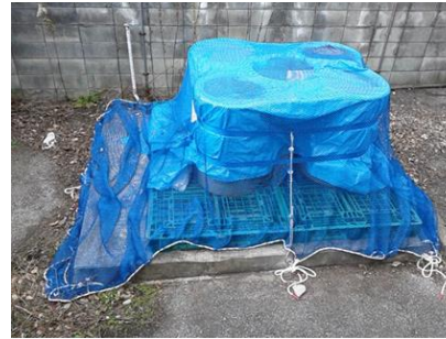
ワイヤーで基礎に固定
