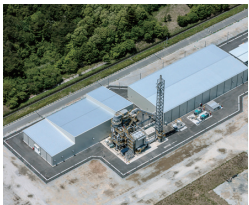
国が東京電力(株)南いわき開閉所の敷地に設置した仮設焼却施設。モニタリングを実施し、安全に焼却が進められています。
