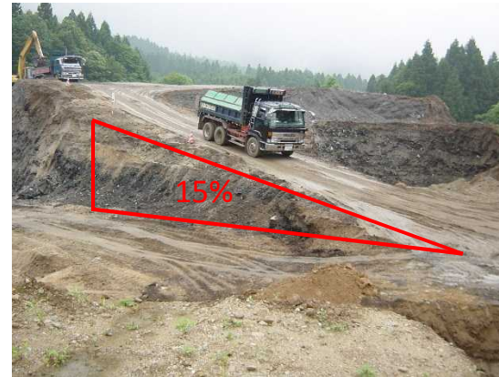
※工事用道路 の例
