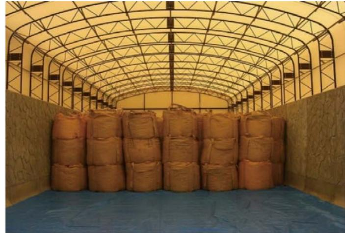
ごみ焼却施設では焼却灰を丈夫な袋に詰めて、テントなどの建屋内で一時保管しています。
