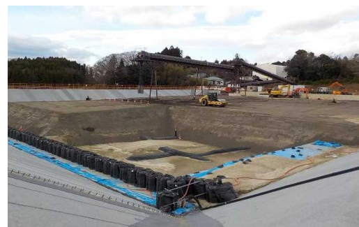
土壌貯蔵施設(双葉1期①工区)
