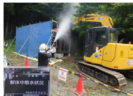
被災家屋等の解体の様子
