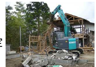
被災家屋等の解体
