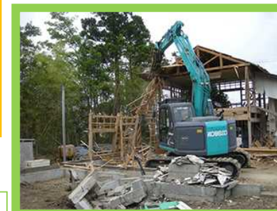
被災家屋等の解体
