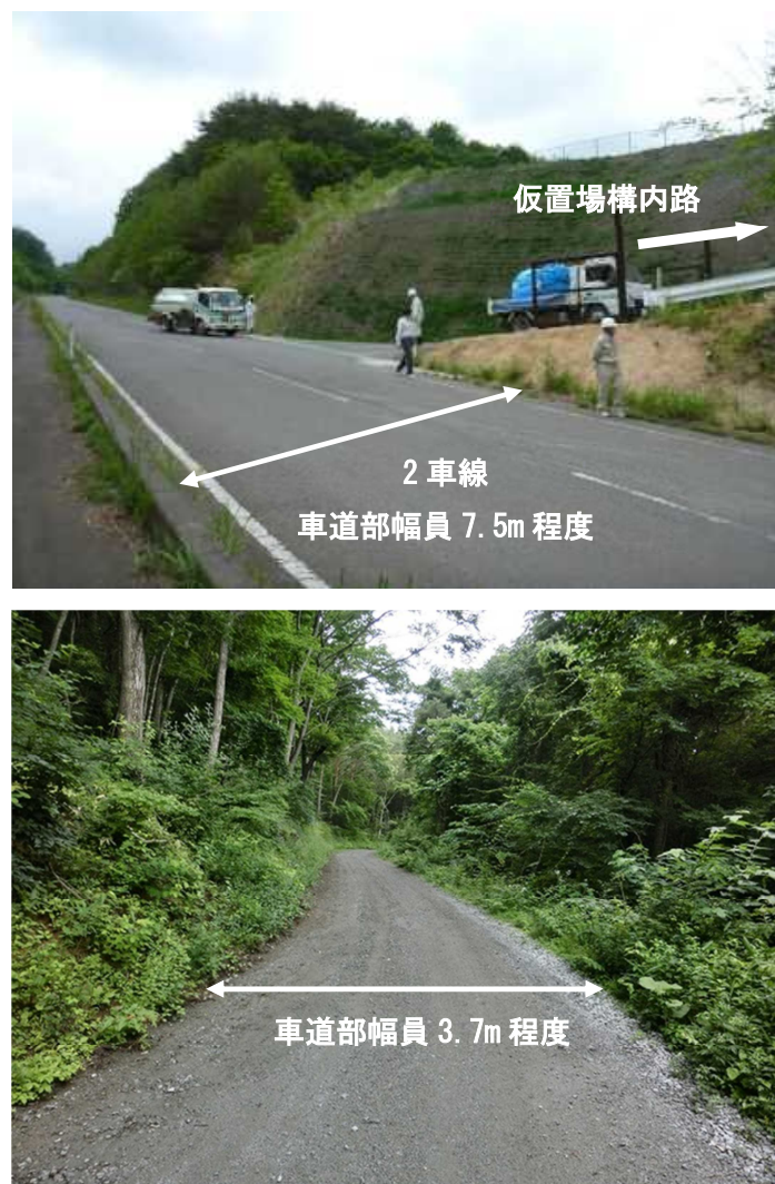
図 1 2 仮置場へのアクセス道路の状況（例）
