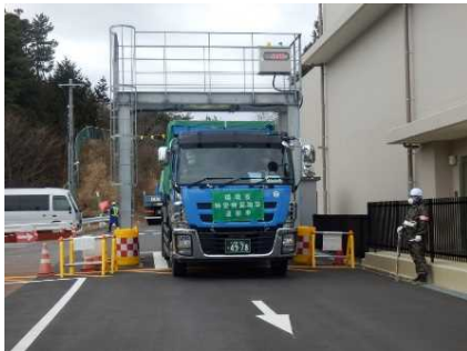
②ゲートモニターによる自動線量計測
