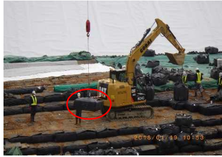
③自動タグ読取、シートはがし、重量計測
