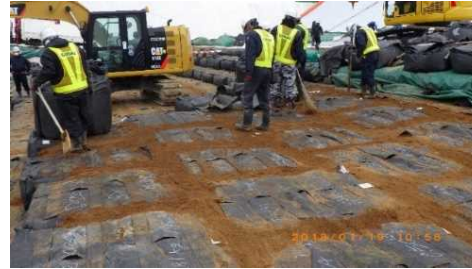
⑤間詰め、転圧作業
