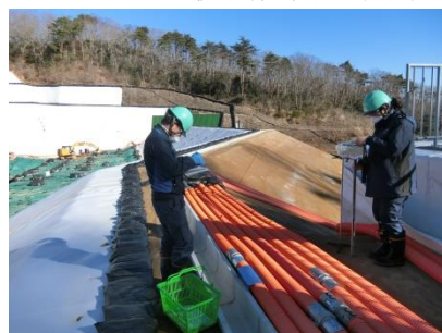
地点 D : 下流側区画の南側
