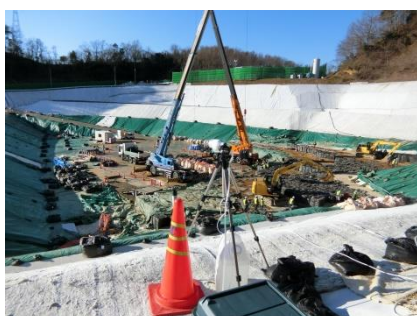
A 北側ダストモニタ建屋付近
