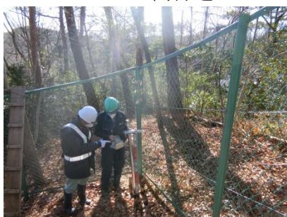
No. 4 下流側区画の北側
