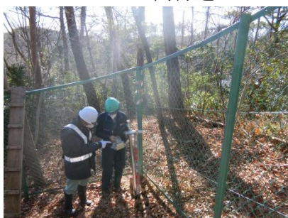
No. 4 下流側区画の北側
