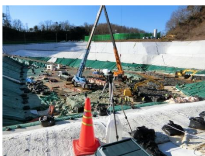
A 北側ダストモニタ建屋付近
