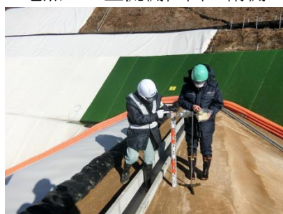
地点 C：下流側区画の北側
