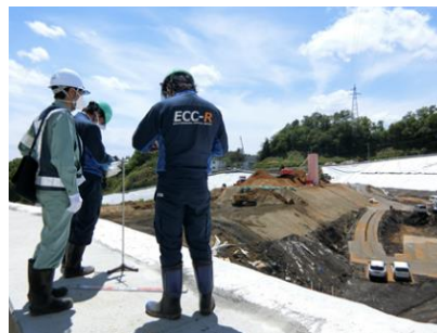
地点 B：上流側区画の北側
