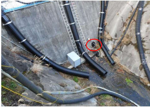
地下水採取地点(○印地点)
