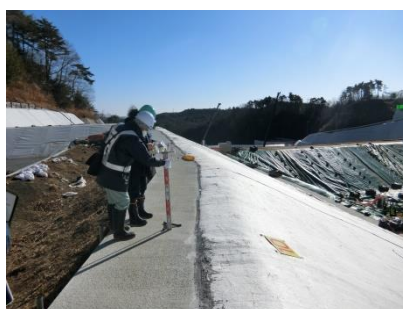
地点 B：上流側区画の北側
