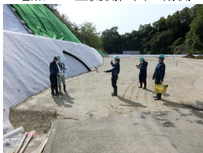
地点 C：下流側区画の北側
