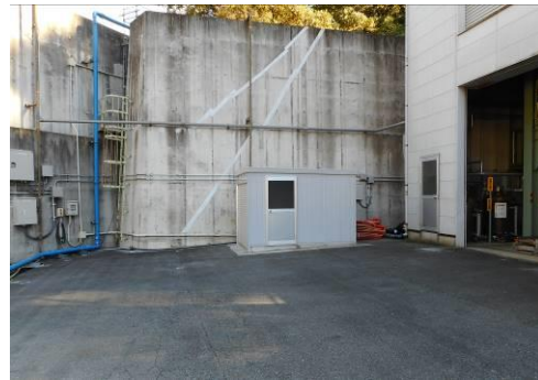
ユニットハウスの状況
