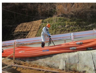
地点 D：下流側区画の南側
