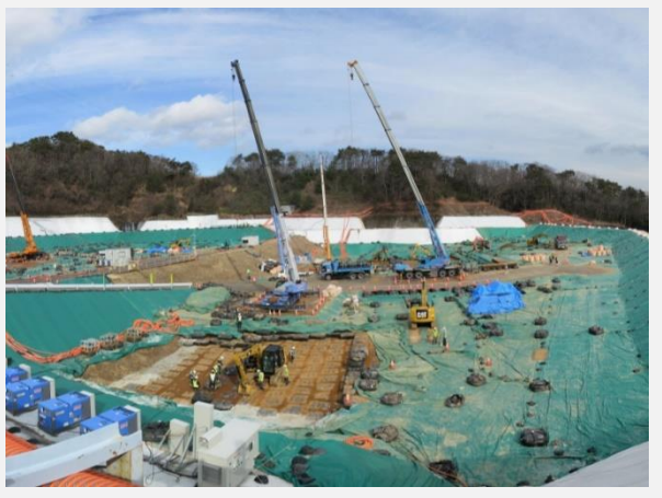
下流側区画の埋立状況
