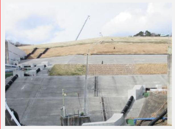
土堰堤法面緑化の状況
