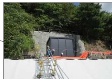
埋立地北側（局舎外観）
