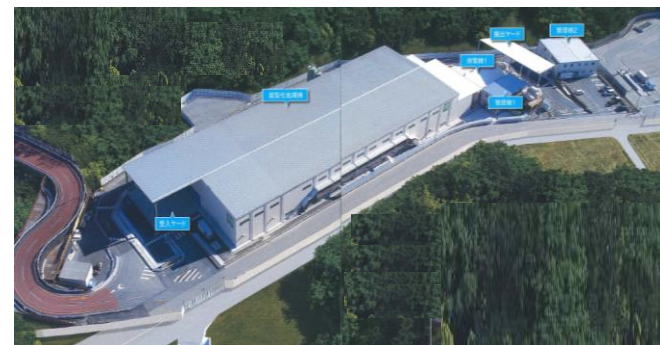
(セメント固型化処理施設 全景)
