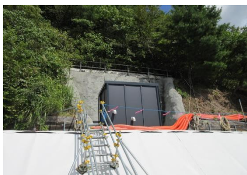
埋立地北側(局舎外観)
