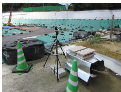
A 北側ダストモニタ建屋付近
