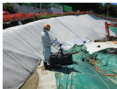
地点 D : 下流側区画の南側
