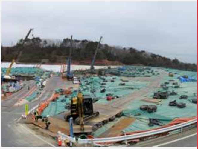
下流側区画の埋立状況
