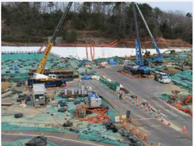
仕切り部の状況
