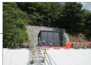
埋立地北側（局舎外観）
