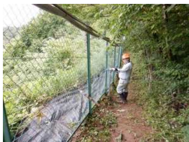
No. 5 下流側区画の南側
