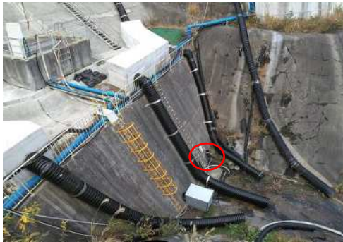
地下水採取地点(○印地点)
