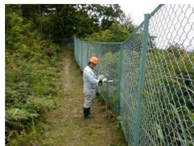
No. 3 上流側区画の北側
