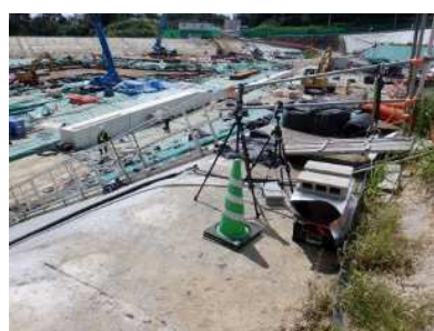
A 北側ダストモニタ建屋付近
