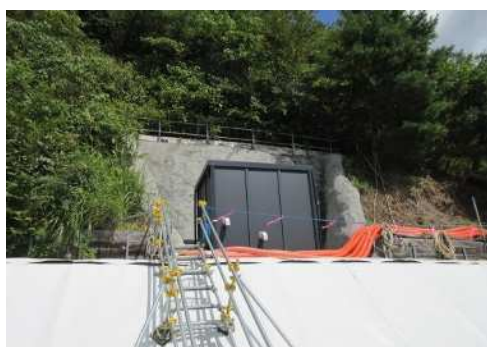
埋立地北側(局舎外観)
