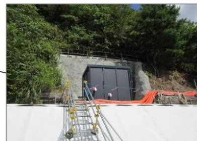
埋立地北側 (ユニットハウス外観)
