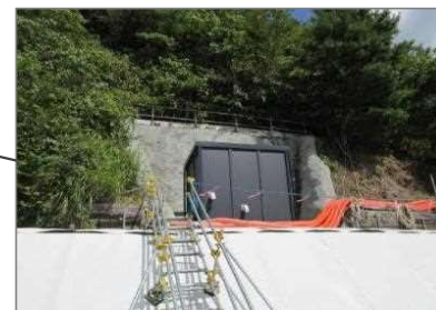
埋立地北側 (ユニットハウス外観)
