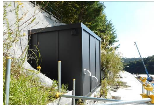
埋立地北側(ユニットハウス近景)
