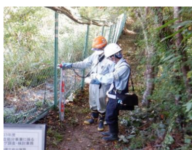
No. 5 下流側区画の南側
