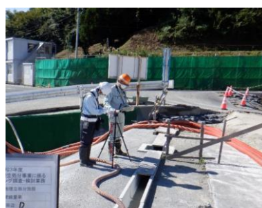
地点 D: 下流側区画の南側
