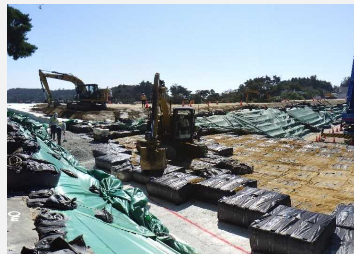
下流側区画の埋立状況
