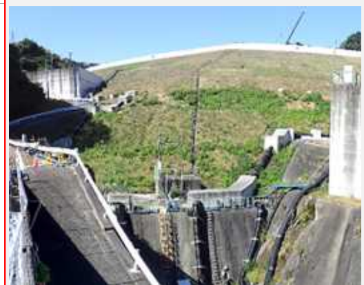
土堰堤法面の状況
