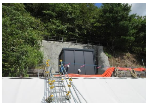
埋立地北側(ユニットハウス外観)
