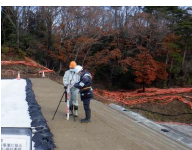
地点 C：下流側区画の北側
