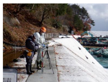
地点 B：上流側区画の北側
