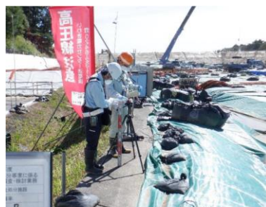
地点 B：上流側区画の北側
