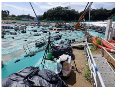
A 北側ダストモニタ建屋付近
