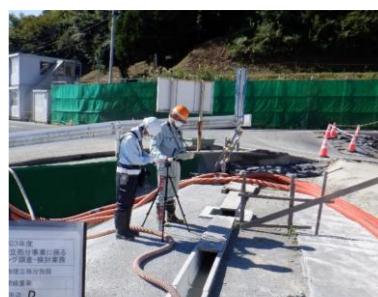
地点 D：下流側区画の南側
