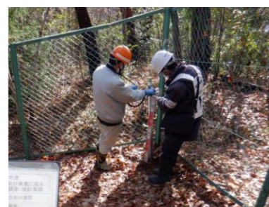
No. 4 下流側区画の北側
