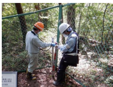
No. 4 下流側区画の北側
