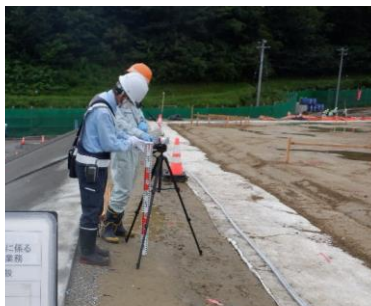
地点 D: 下流側区画の南側
