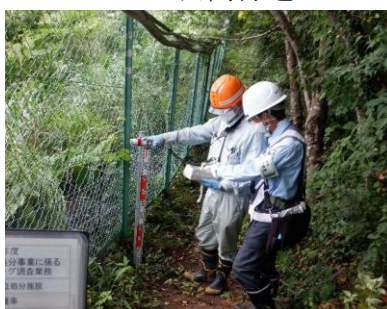
No. 5 下流側区画の南側
