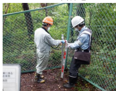
No. 4 下流側区画の北側
