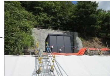
埋立地北側 （ユニットハウス外観） ※令和4年4月11日以降、一時撤去
