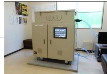
業務棟の測定装置
