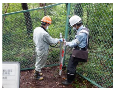
No. 4 下流側区画の北側
