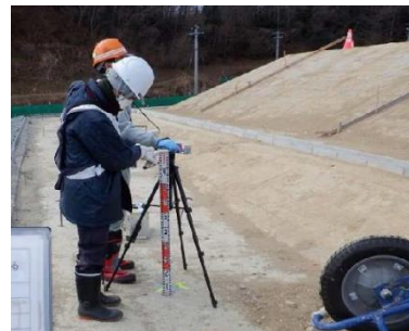
地点 D：下流側区画の南側
