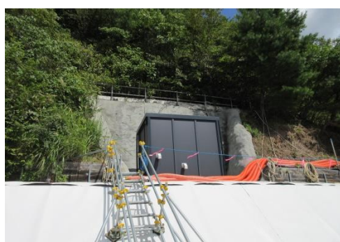
埋立地北側(ユニットハウス外観)
