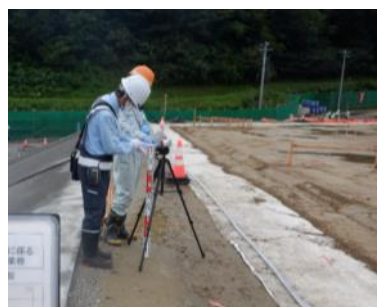
地点 D：下流側区画の南側
