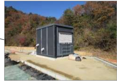
埋立地北側 (ユニットハウス外観)
