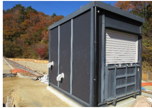
埋立地北側(ユニットハウス近景)
