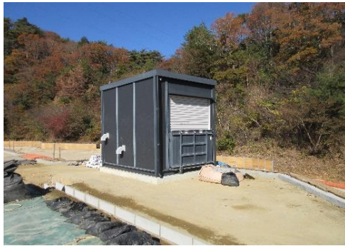
埋立地北側(ユニットハウス外観)
