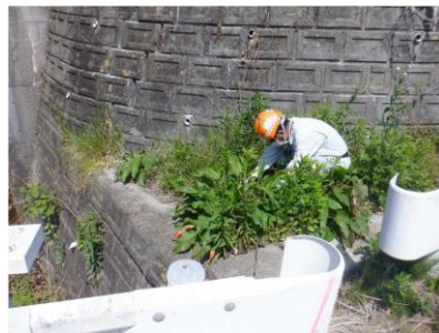
調査地点④ (撮影日:令和5年5月17日)
