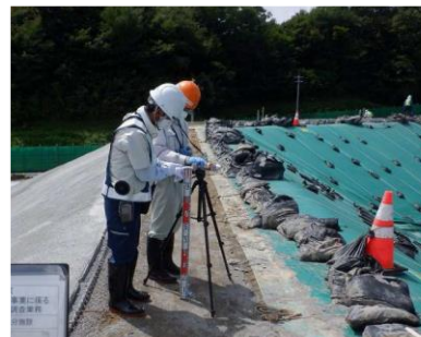
地点 D : 下流側区画の南側
