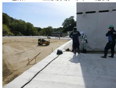
地点 D：下流側区画の南側
