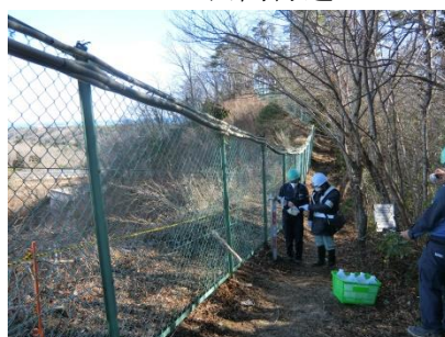
No. 5 下流側区画の南側
