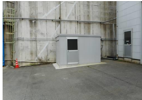
ユニットハウスの状況
