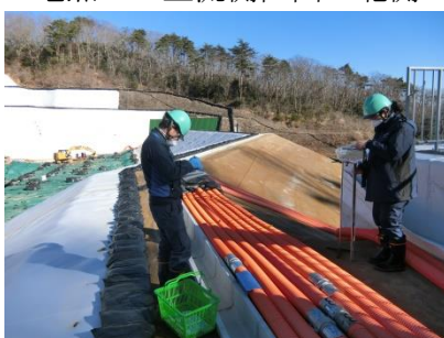
地点 D：下流側区画の南側
