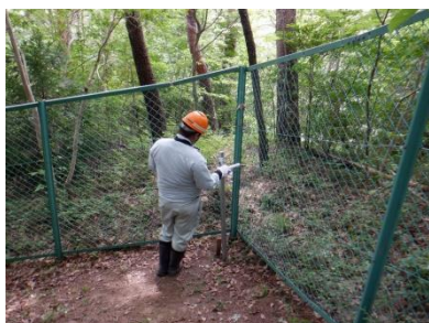
No. 4 下流側区画の北側
