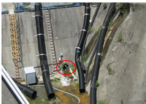
地下水採取地点(○印地点)
