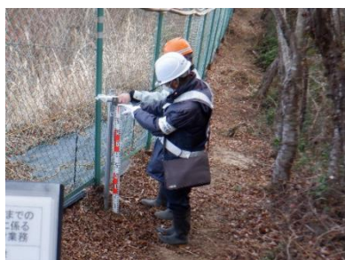
No. 5 下流側区画の南側
