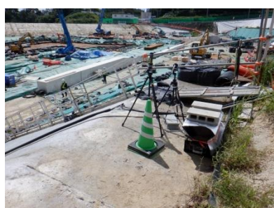
A 北側ダストモニタ建屋付近
