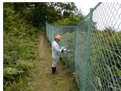
No. 3 上流側区画の北側
