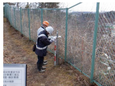
No. 3 上流側区画の北側
