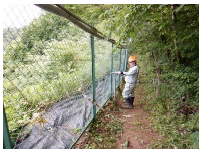
No. 5 下流側区画の南側
