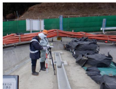
地点 D: 下流側区画の南側
