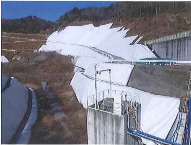
図2 2016年2月19日の現場状況（右岸側より埋立地を撮影）
