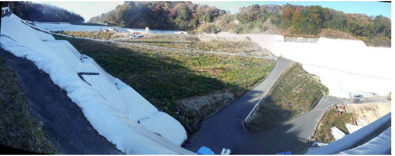
図-1.2 2016年11月18日の現場測定時状況（中継端子付近の天端部より埋立地を撮影）
