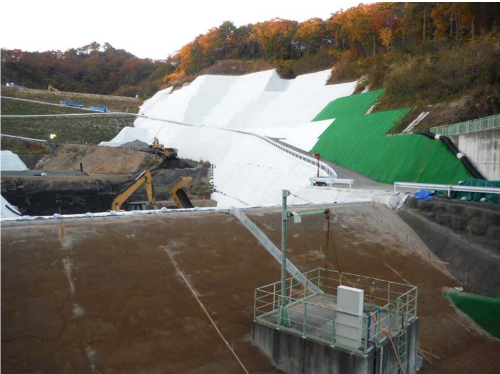
図-1.2 2016年11月18日の現場状況（南側より埋立地を撮影）
