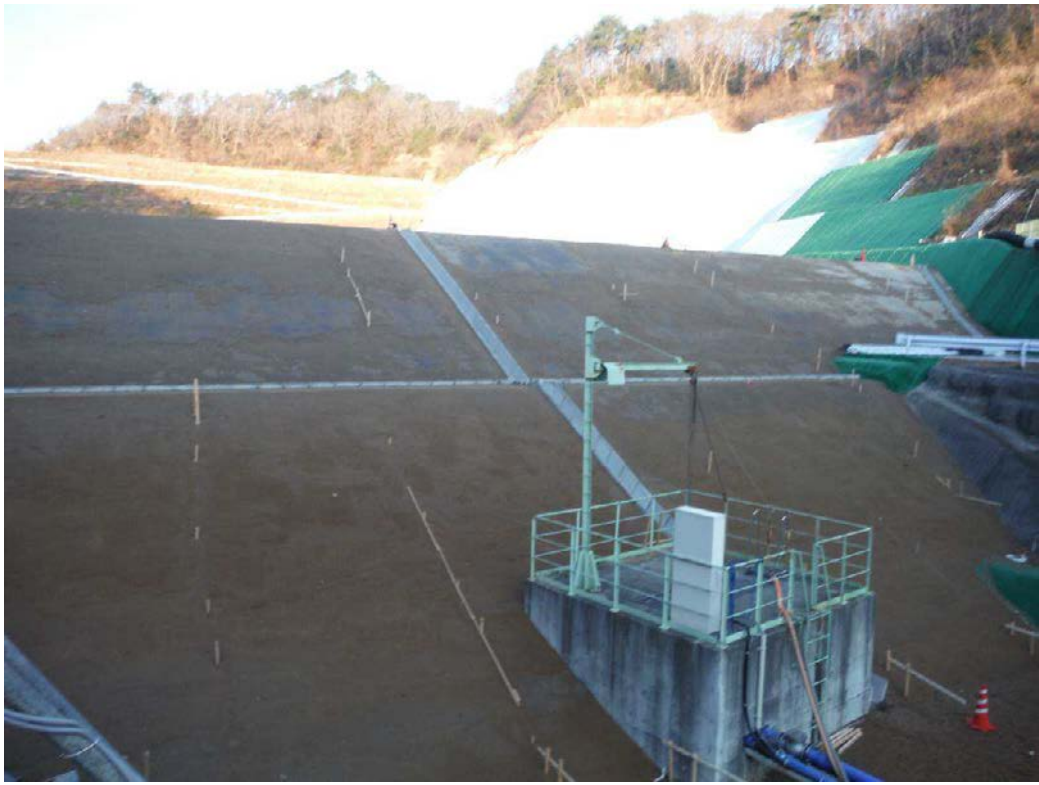
図-1.2(1) 南側より埋立地(土堰堤)側
