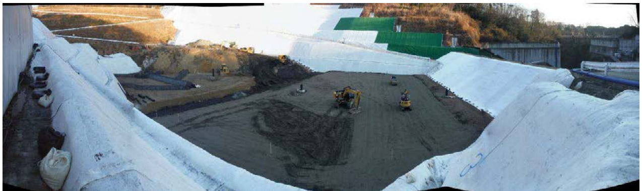
図-1.2(2) 新設調整槽より下流側埋立地
