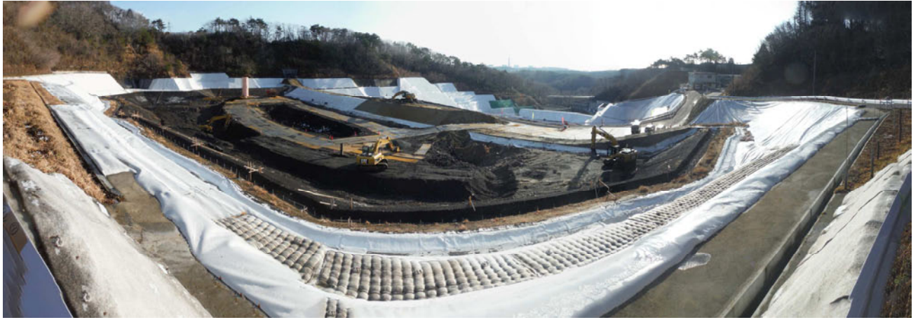
図-1.2(1) 西門付近より上流側埋立地
