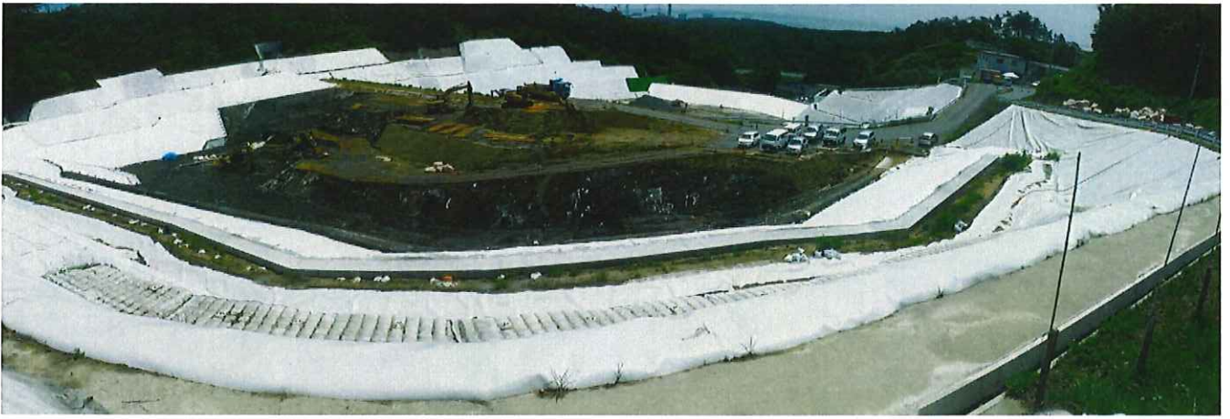
図-1.2(1) 西門付近より上流側埋立地
