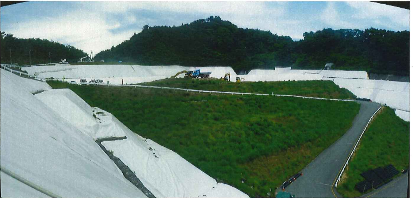
図-1.2(2) 上流側中継端子盤付近より上流側埋立地
