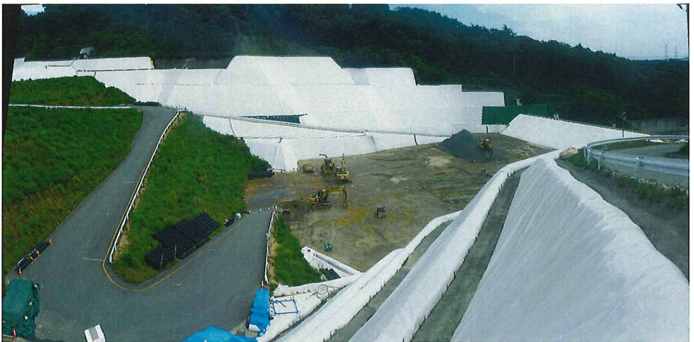
図-1.2(2) 上流中継端子盤付近より下流側埋立地
