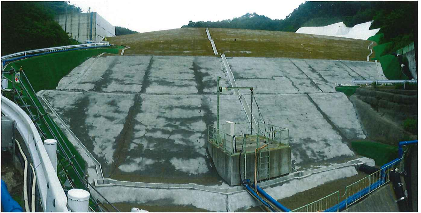
図-1.2(1) 下流中継端子盤付近より埋立地(土堰堤)側
