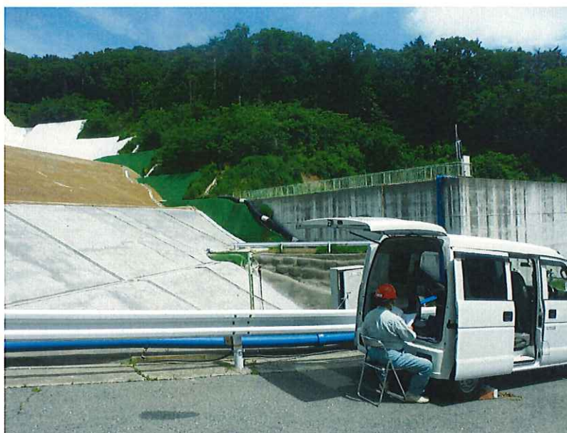
図-2.1(1) 測定機器設置(測定)状況
