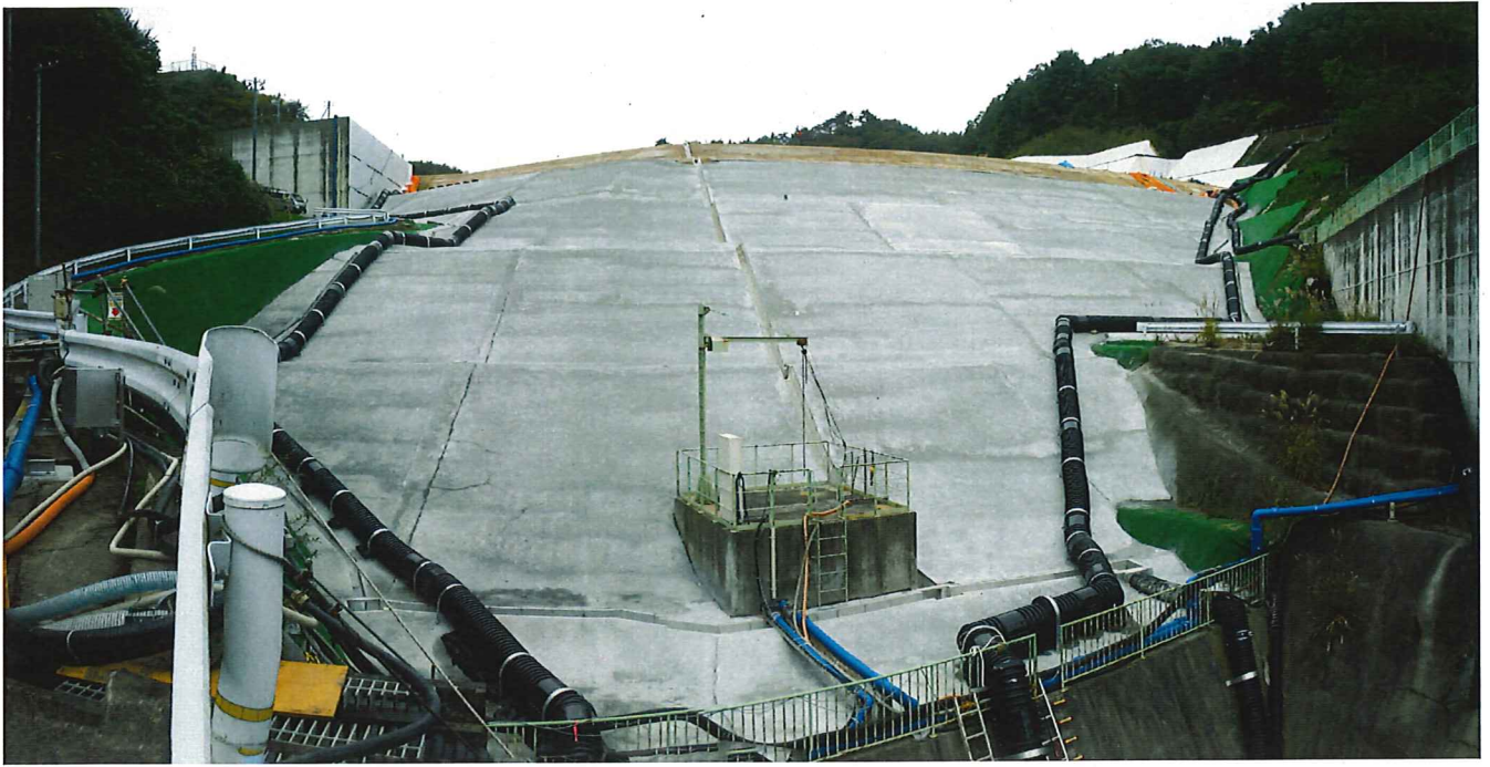
図-1.2(1) 下流中継端子盤付近より埋立地(土堰堤)側
