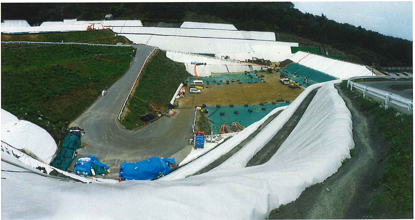
図-1.2(2) 上流中継端子盤付近より下流側埋立地
