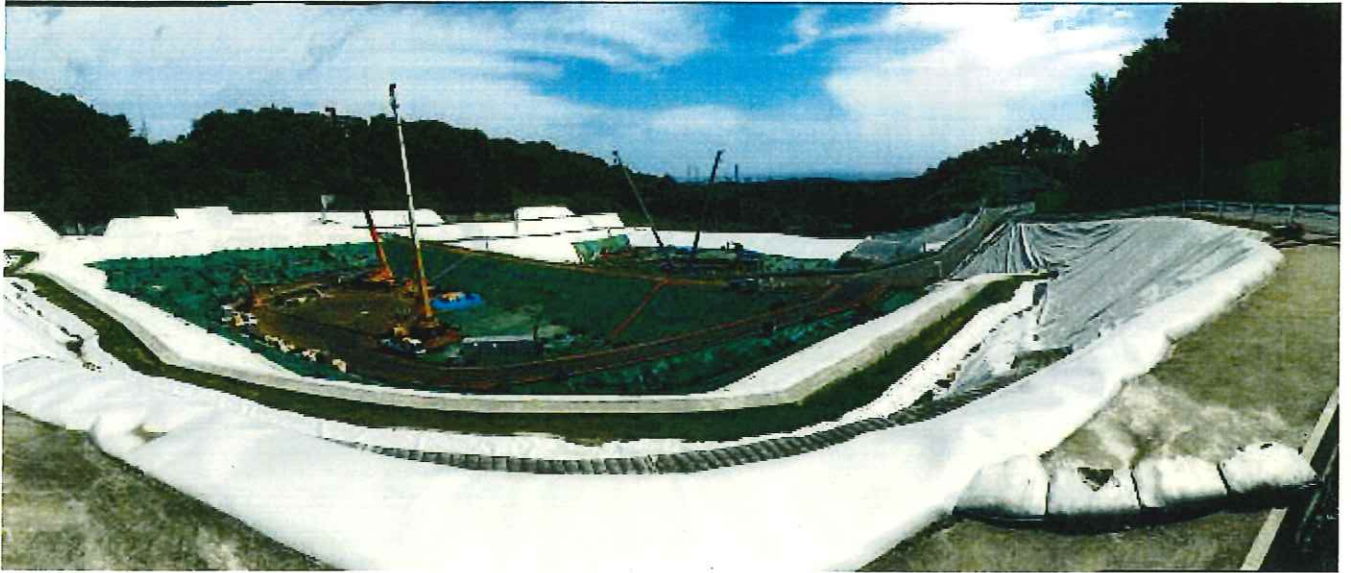
図-1.2 西門付近より上流側埋立地
