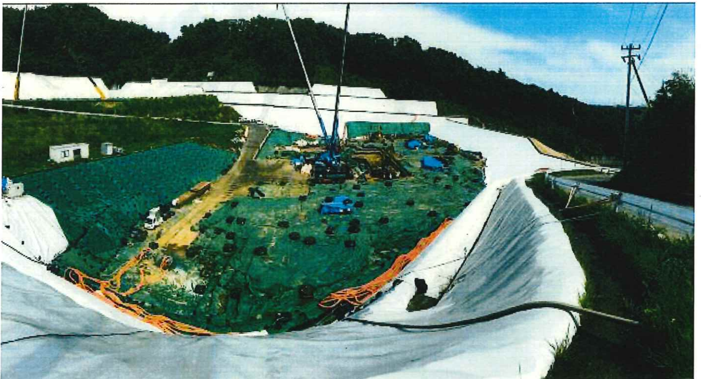
図-1.3 上流中継端子盤付近より下流側埋立地
