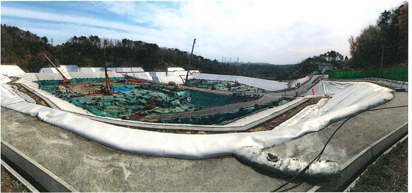
図-1.2 西門付近より上流側埋立地
