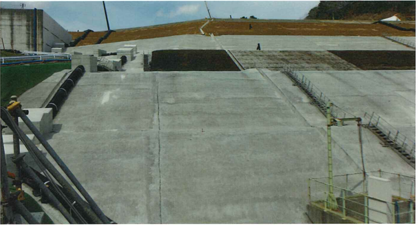
図-1.2 下流中継端子盤付近より埋立地(土堰堤)側
