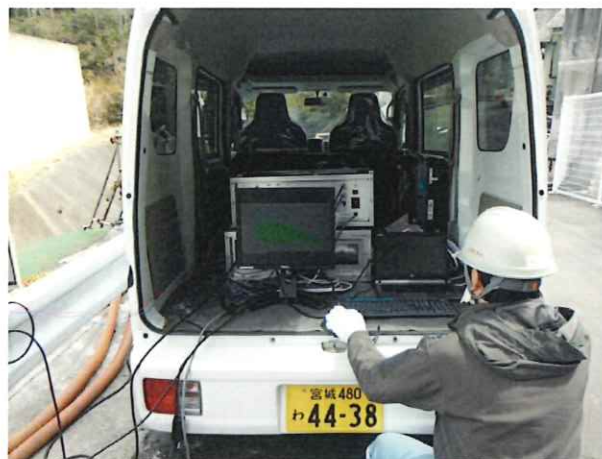
図-2.1 測定機器設置(測定)状況
