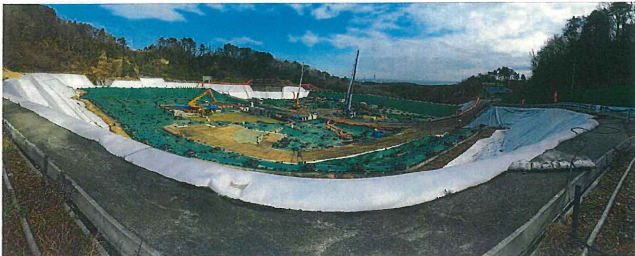
図-1.2 西門付近より上流側埋立地
