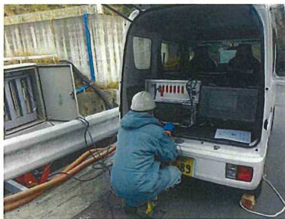
図-2.1 測定機器設置(測定)状況
