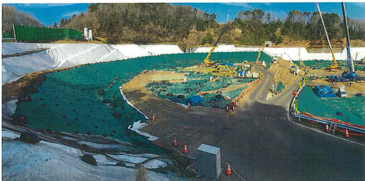
図-1.3 上流側中継端子盤付近より上流側埋立地
