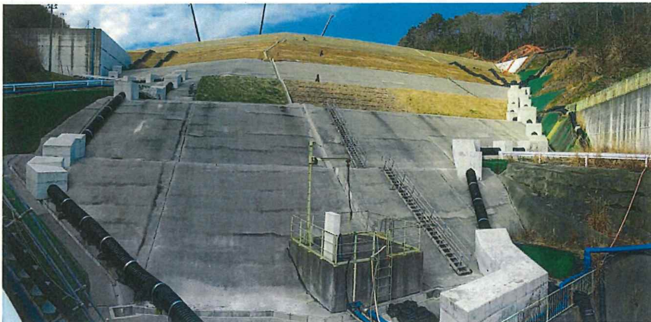
図-1.2 下流中継端子盤付近より埋立地(土堰堤)側
