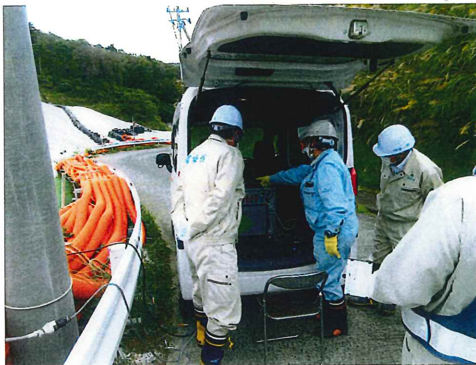
図-2.1 計測機器設置（測定）状況
