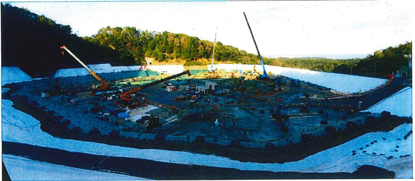
図-1.2 西門付近より上流側埋立地
