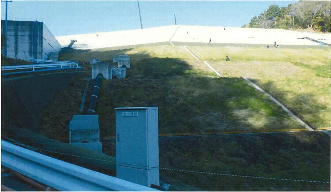
図-1.2 下流中継端子盤付近より埋立地(土堰堤)側
