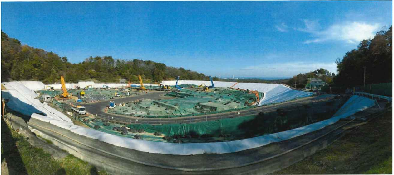
図-1.2 西門付近より上流側埋立地
