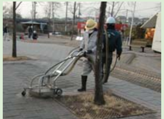
こうあつすいせんじょう コンクリートの高圧水洗浄
